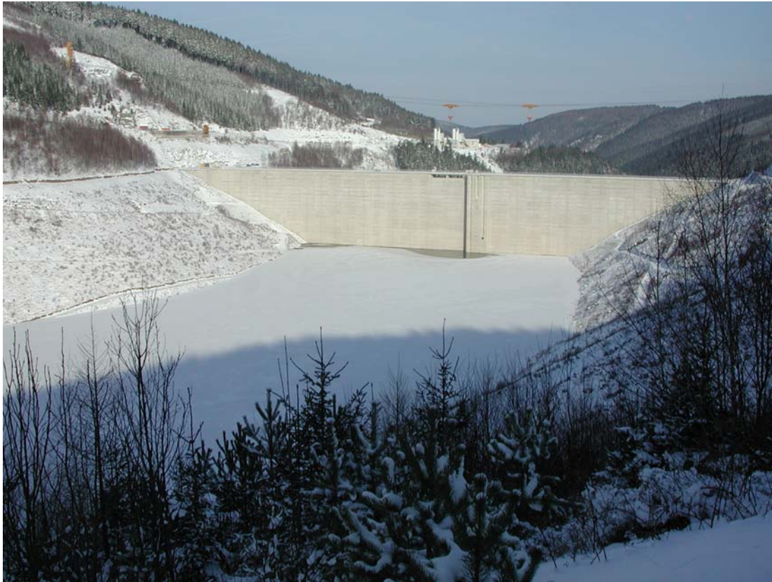
Bild 1: Talsperre Leibis/Lichte im Ersteinstau, Februar 2006; Stauinhalt, bis zu dem im späteren Betrieb nach Wasserwirtschaftsplan [6] die Talsperre regulär abgesenkt werden dürfte
